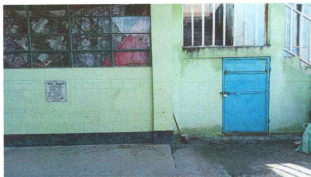
FOTO 8. PINTURA EN MUROS EXTERIORES E INTERIORES EN AULAS
