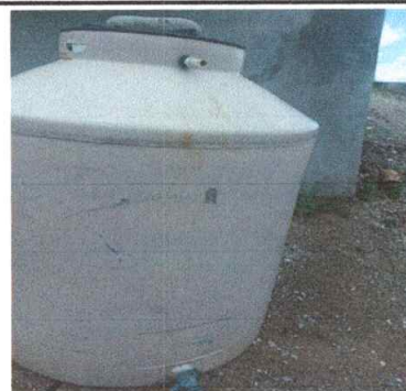
Foto 8: SUSTITUCIÓN DE TINACOSDE 2500LTS TALIShte EN BAÑOS
