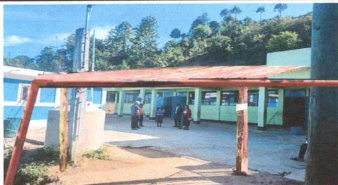
Foto 1: SUSTITUCIÓN DE LÁMINA POR LÁMINA TROQUELADA CALIBRE 26
