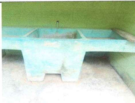
Foto 7: SUSTITUSION DE PILAS DE CEMENTO EN BAÑOS
