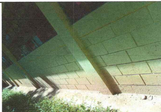
FOTO 9. PINTURA EN MUROS EXTERIORES E INTERIORES EN AULAS
