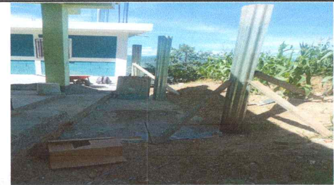
Foto 4: REPARACIÓN DE TUBO DE TUBO HG Y MALLA GALVANIZADA
