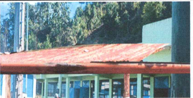
Foto 5: SUSTITUCIÓN DE CANAL PVC3" EN PATIO
