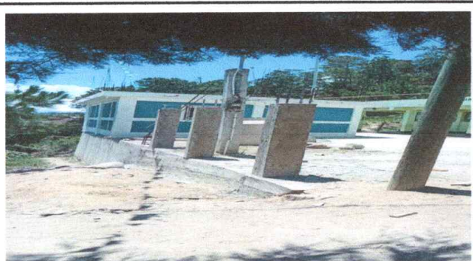
Foto 3: REPARACIÓN DE TUBO DE TUBO HG Y MALLA GALVANIZADA
